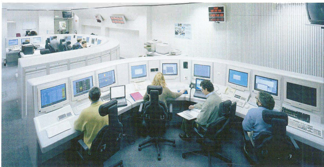
Salle de contrôle polyvalente
